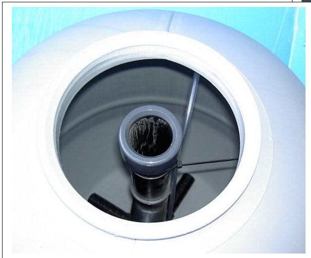
Bild 9 Dichtschaube aus dem 6-Wegeventil wird entfernt
