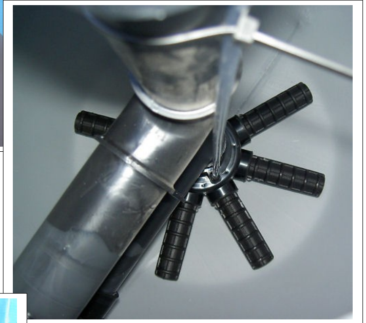
Bild 7 der Filterstern im Kesselinneren
