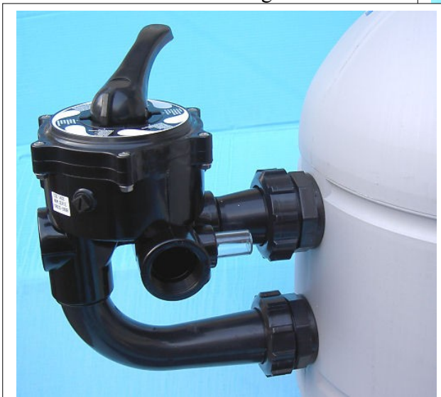
Bild 4 das vorbereitete 6- Wegeventil mit Teflonband eingedichtet ---->
